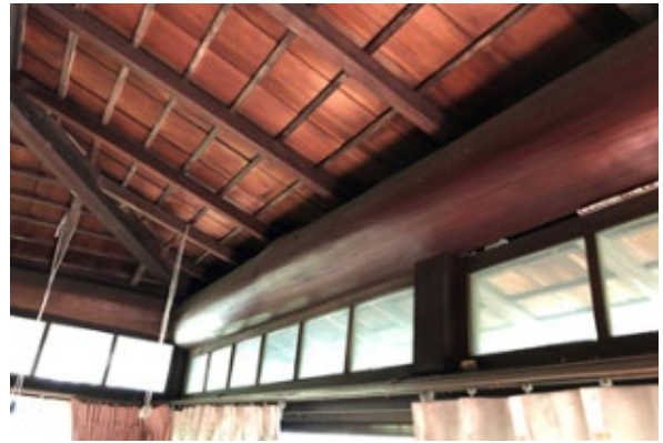
既存住宅内の「大梁」
