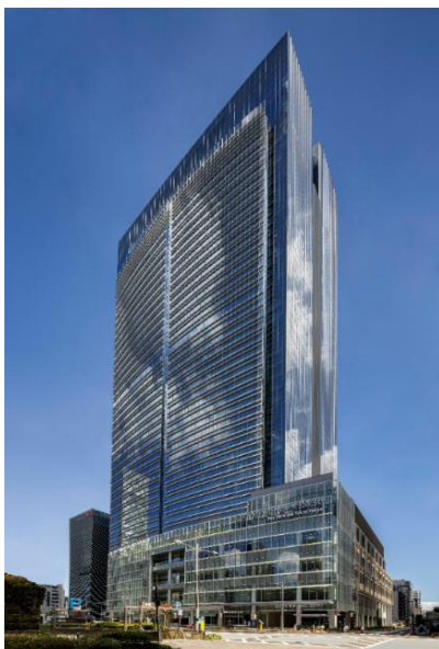
東京ミッドタウン八重洲 八重洲セントラルタワー
