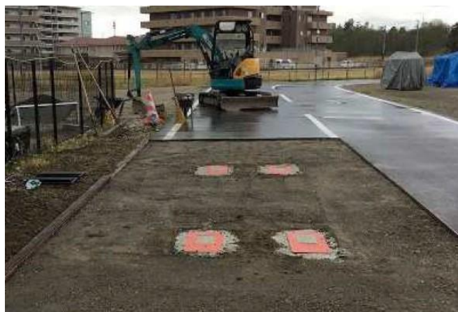
送電コイルの埋設
