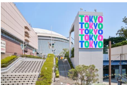
<プリズムホール塔体ビジョン>
