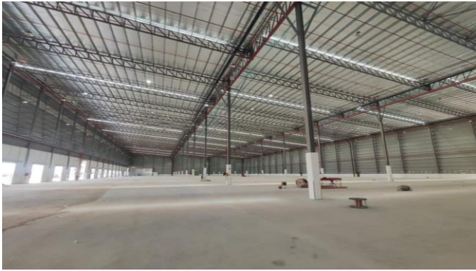
倉庫エリア（第1期）
