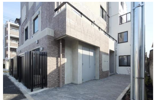
改修後 エントランス位置変更(右奥)
