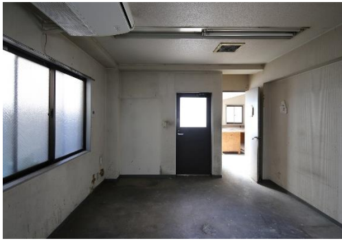
改修前 作業所・事務所部分
