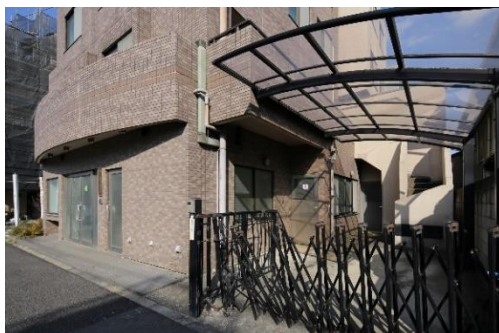
改修前 エントランス(左奥)
