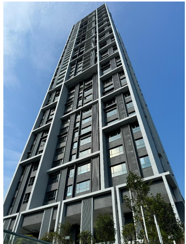
三井サービススイート ブキッ・ビンタン シティ センター 外観
