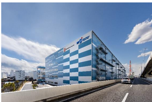
高速道路から見た外観
