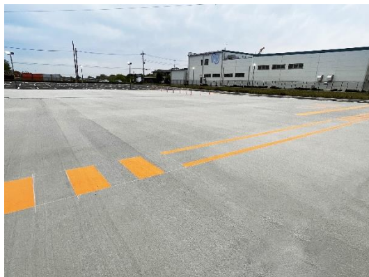
ダブル連結トラック荷捌きエリア
