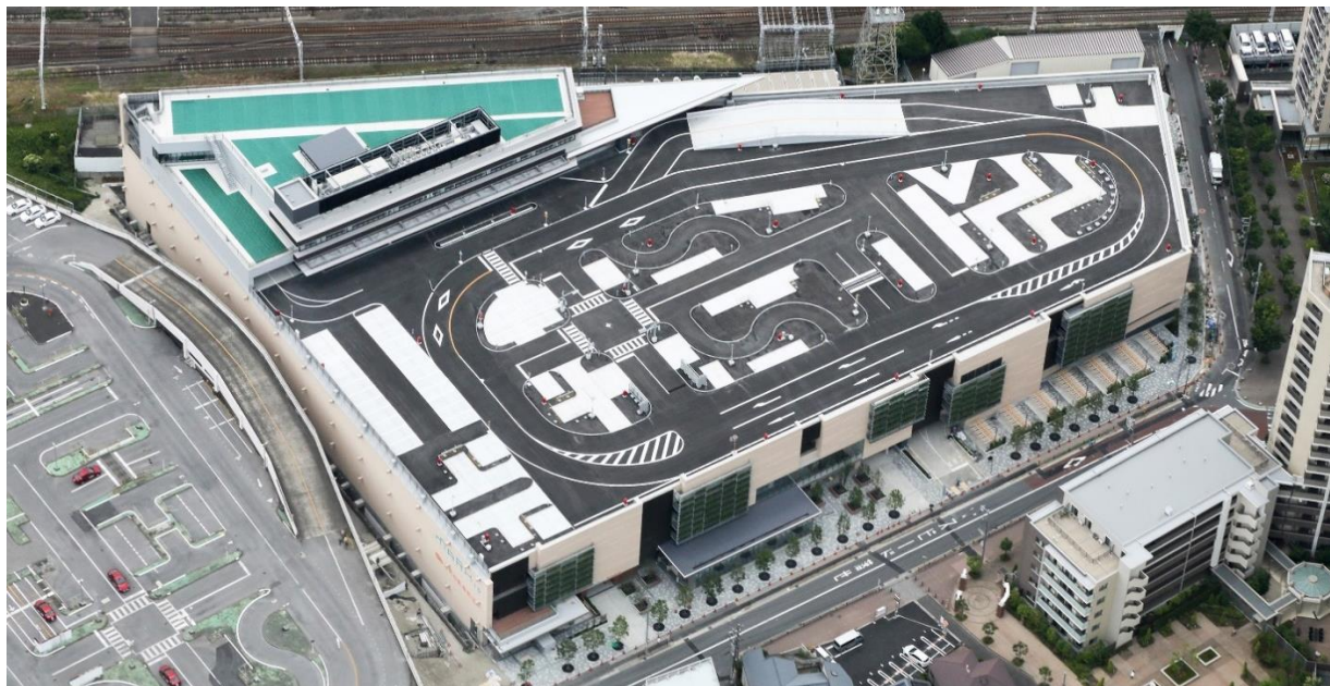
▲ I 期施設屋上（北東より）
