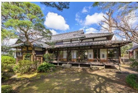
耐震改修工事前
