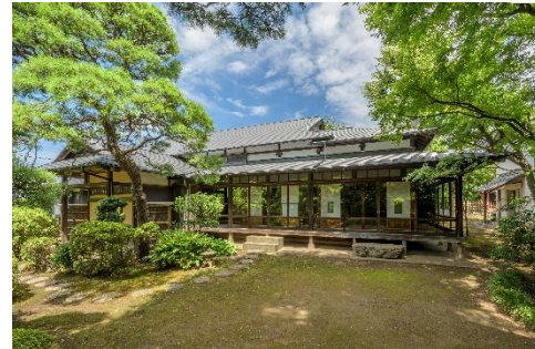
耐震改修工事後
