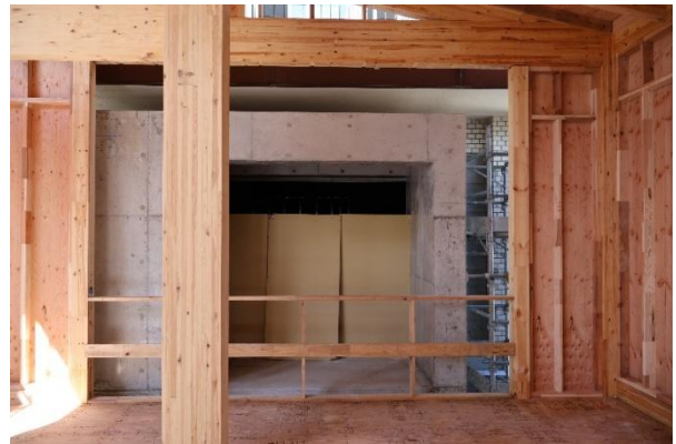
木構造に接続された火熱遮断壁（施工時写真）
