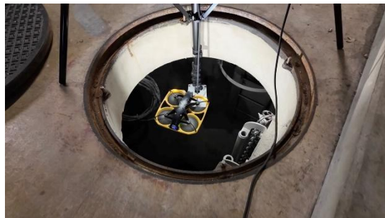
<マンホールに入る様子>
