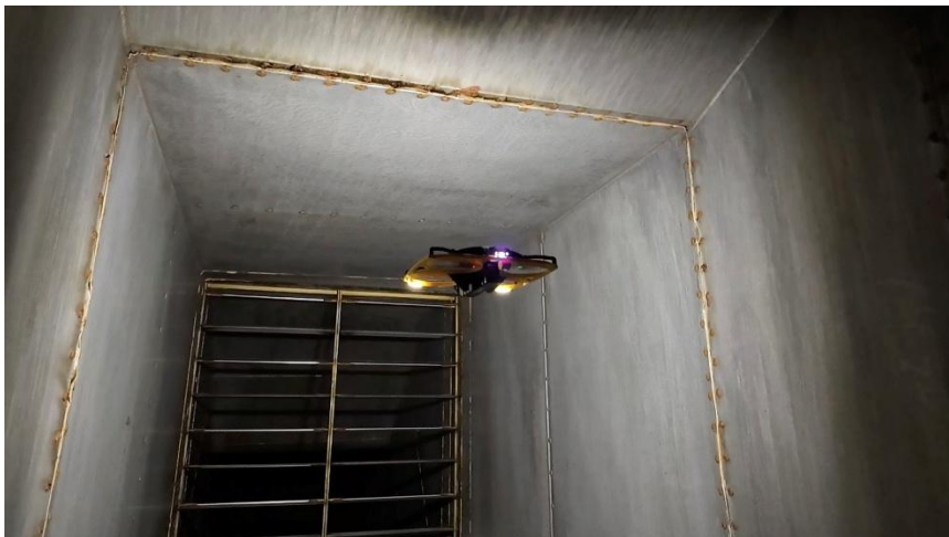
ダクト内部を飛行する様子
