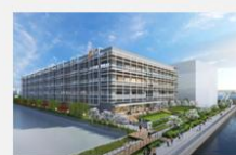
三井リンクラボ東陽町 1
