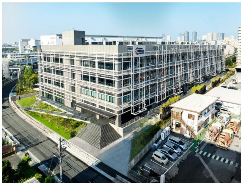
「三井リンクラボ東陽町 1」外観
