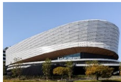
LaLa arena TOKYO-BAY （千葉県船橋市）
