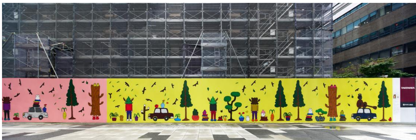
「日本橋本町三井ビルディング &forest」の工事用仮囲い装飾 © Yuichi Hirako photo by Osamu Sakamoto
