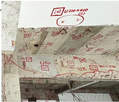
建物の不良箇所の調査
