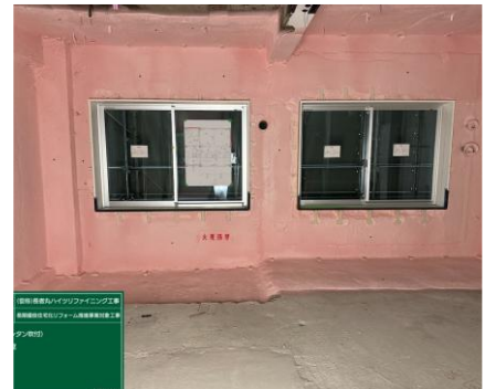
省エネ化のための断熱工事
