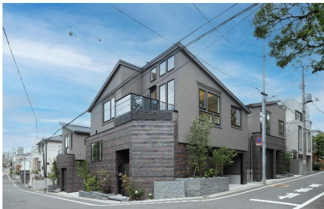
外観竣工写真（2 号棟）
