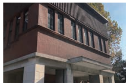
東京大学南研究棟内アントレプレナーラボ
