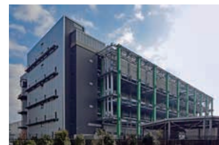
データセンター 三井不動産インダストリアルパーク (MFIP 印西Ⅱ)
