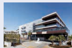
三井不動産ロジスティクスパーク市川塩浜Ⅱ (MFLP市川塩浜Ⅱ) 千葉県市川市 (2022年3月竣工)
