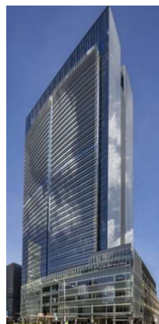
東京ミッドタウン八重洲 八重洲セントラルタワー Tokyo Midtown Yaesu, Yaesu Central Tower
