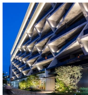
【Exterior view (night)】
