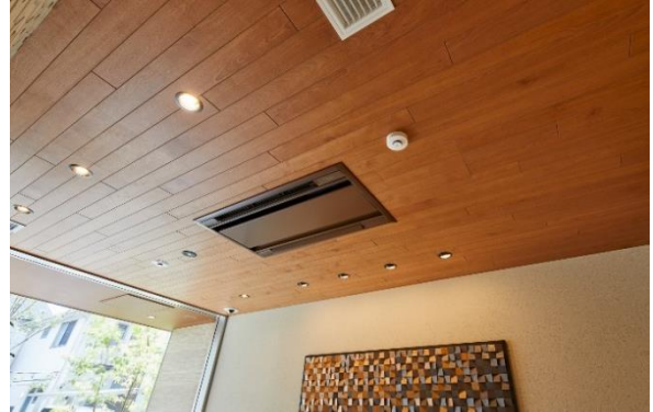
【Entrance lounge ceiling】
