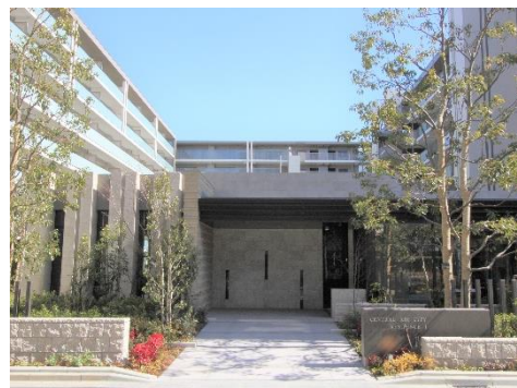
建物エントランス
